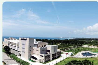
變電站新建工程
