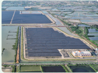
▼ 台電台南鹽田150MW太陽光電
