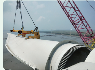
▼ 台泥綠能及星寶電力風機統包工程
