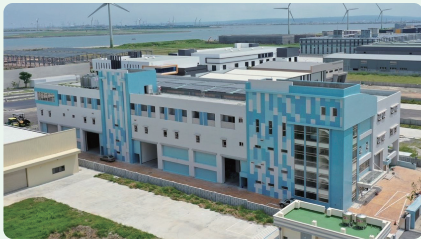
全台首座再生能源運維中心
