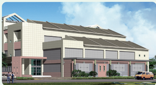
台電週美一次變電所
