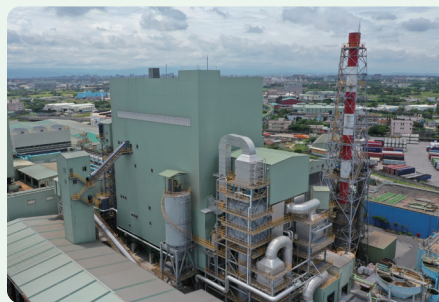
大園G2擴建工程
